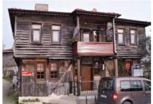
Bir cephede 'yalı baskısı' diğer cephede 'dizeme' kaplama örneği (solda) ve zemin katta 'dizeme', üst kat 'yalı baskısı' kaplama (sağda)
